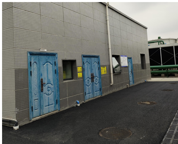
污水处理站废气治理装置房
